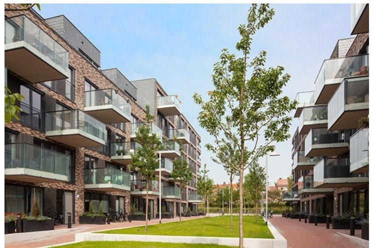
Figuur 41, hoogteverschillen en plastic in de gevel en doorsnijding (Heelmeesters Amsterdam)
